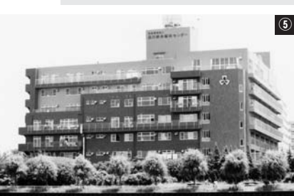
品川総合福祉センター。特別養護老人ホーム、障害者施設など複合施設／昭和58年
